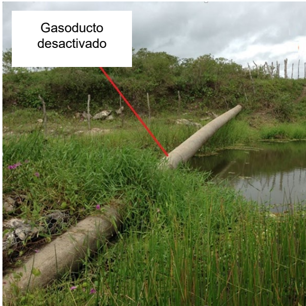
Figura 6.29 Ducto que muestra la posición del lecho del río, cuando éste se encontraba subterráneo (ducto desactivado-fuera de operación)
