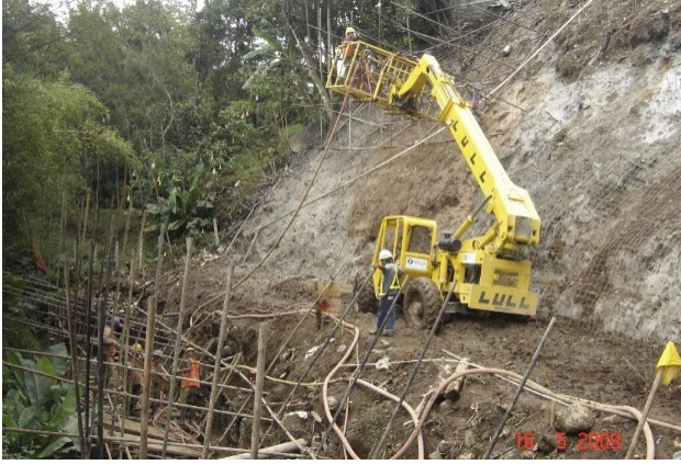
Figuras 9.11 Vista general del talud y colocación de anclajes en la base.
