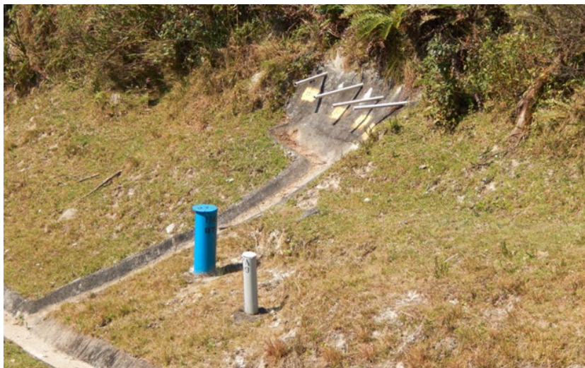
Figura 6.35 Mantenimiento en la identificación de los instrumentos
