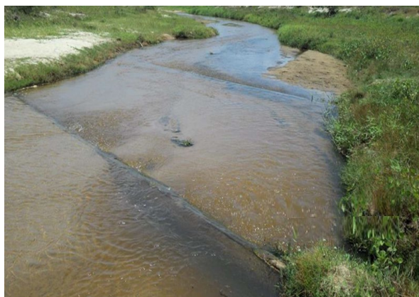
Figura 6.28 Lecho con necesidad de mantenimiento correctivo para lograr cobertura para protección mecánica
