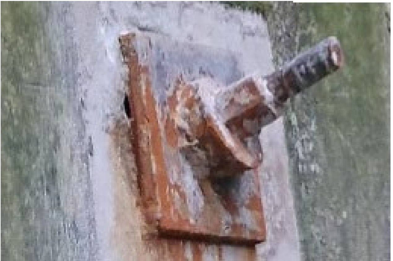
Figura 6.27 Cabeza de tirante después del retiro del cabezal de protección, con necesidad de pintura
