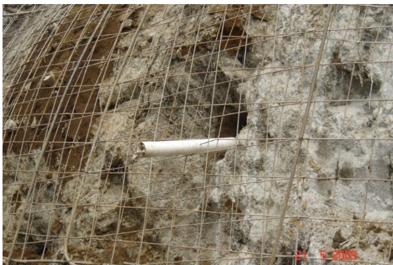
Figuras 9.10 Vista de detalle de talud revestido (izquierda). Vista general de instalación de anclajes en la base del talud (derecha)
