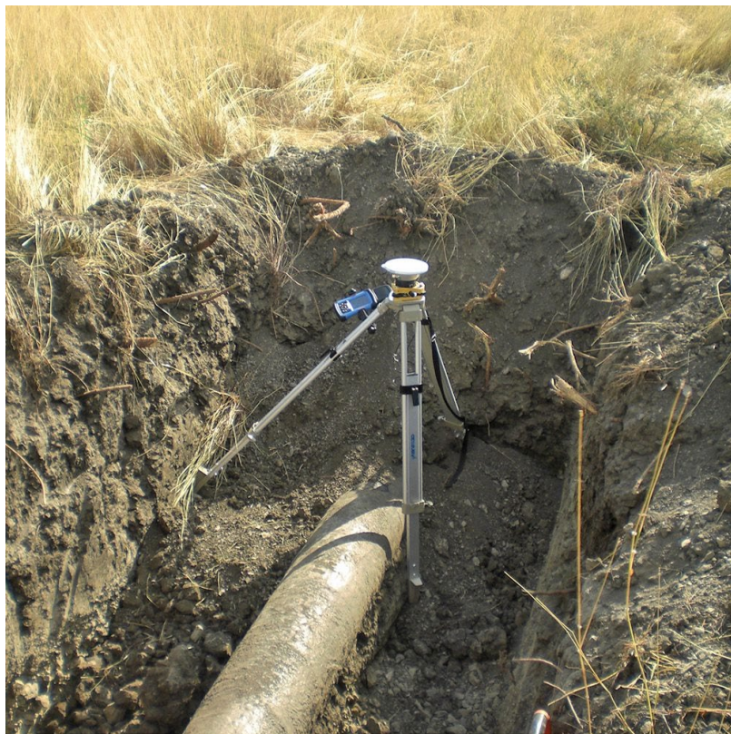
Figura 6.40 Ejemplo de ubicación topográfica del ducto excavado
