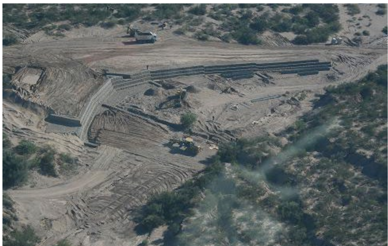
Figura 3.13: Obra de protección de margen con gaviones – etapa de construcción
