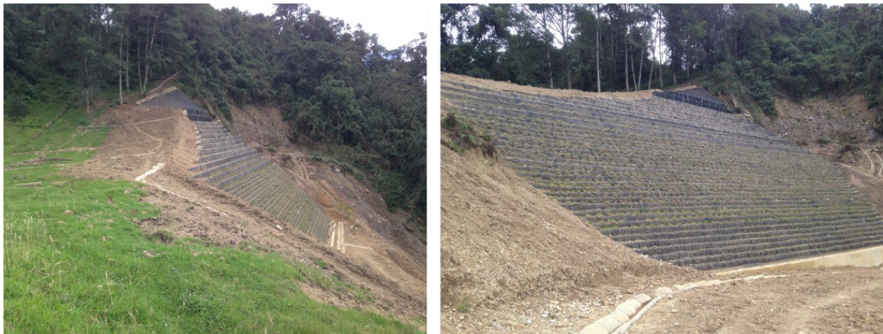
Figura 9.37. Estructura de contención tipo muro reforzado con geomalla terminado
