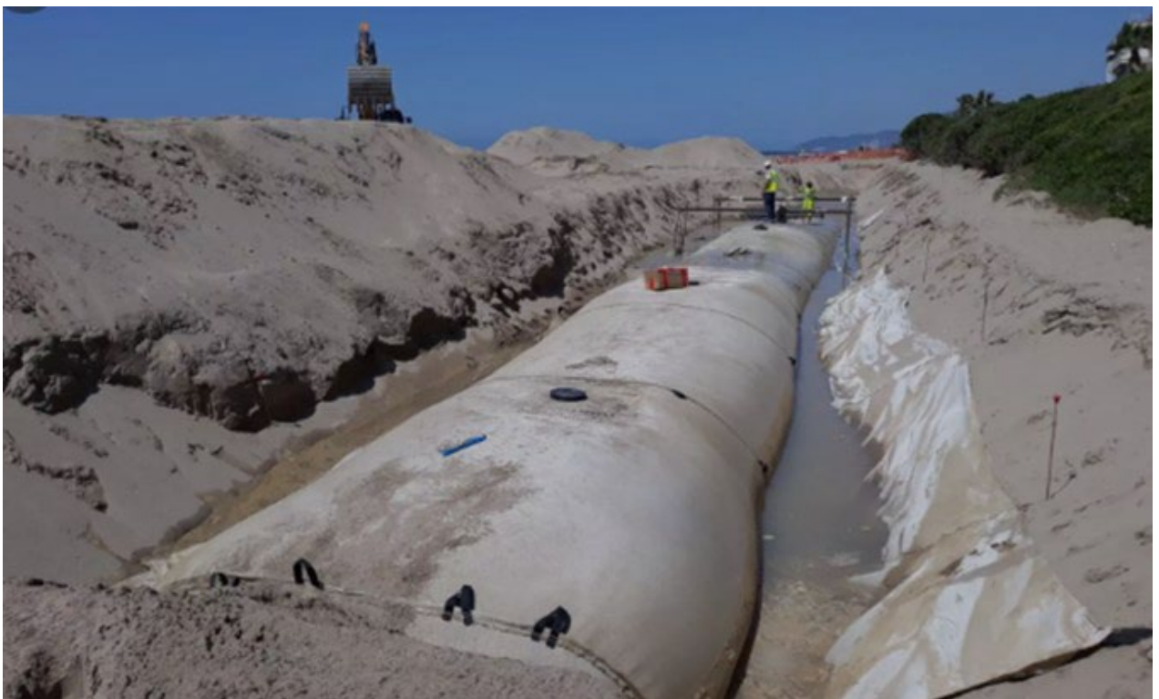
Figura 3.40: Reconformación con Geotubos
