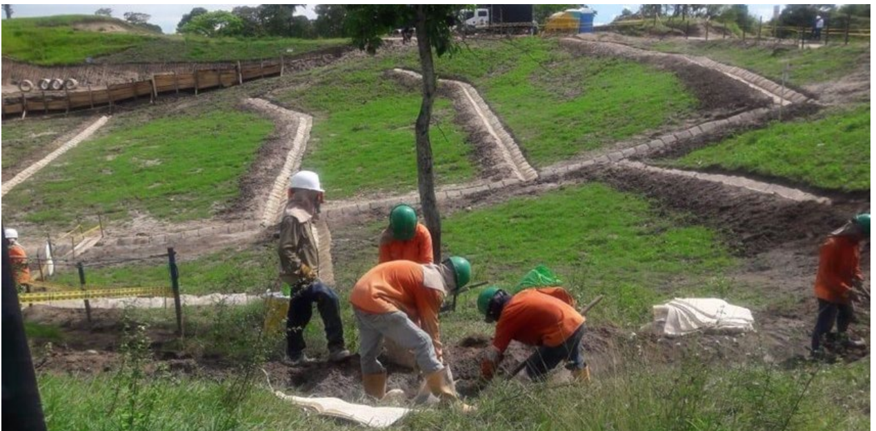
Figura 6.5 Manejo superficial de aguas mediante canales de saco suelo cemento
