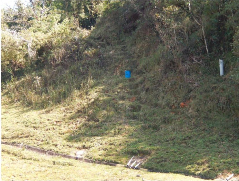
Figura 6.33 Mantenimiento de accesos a los instrumentos
