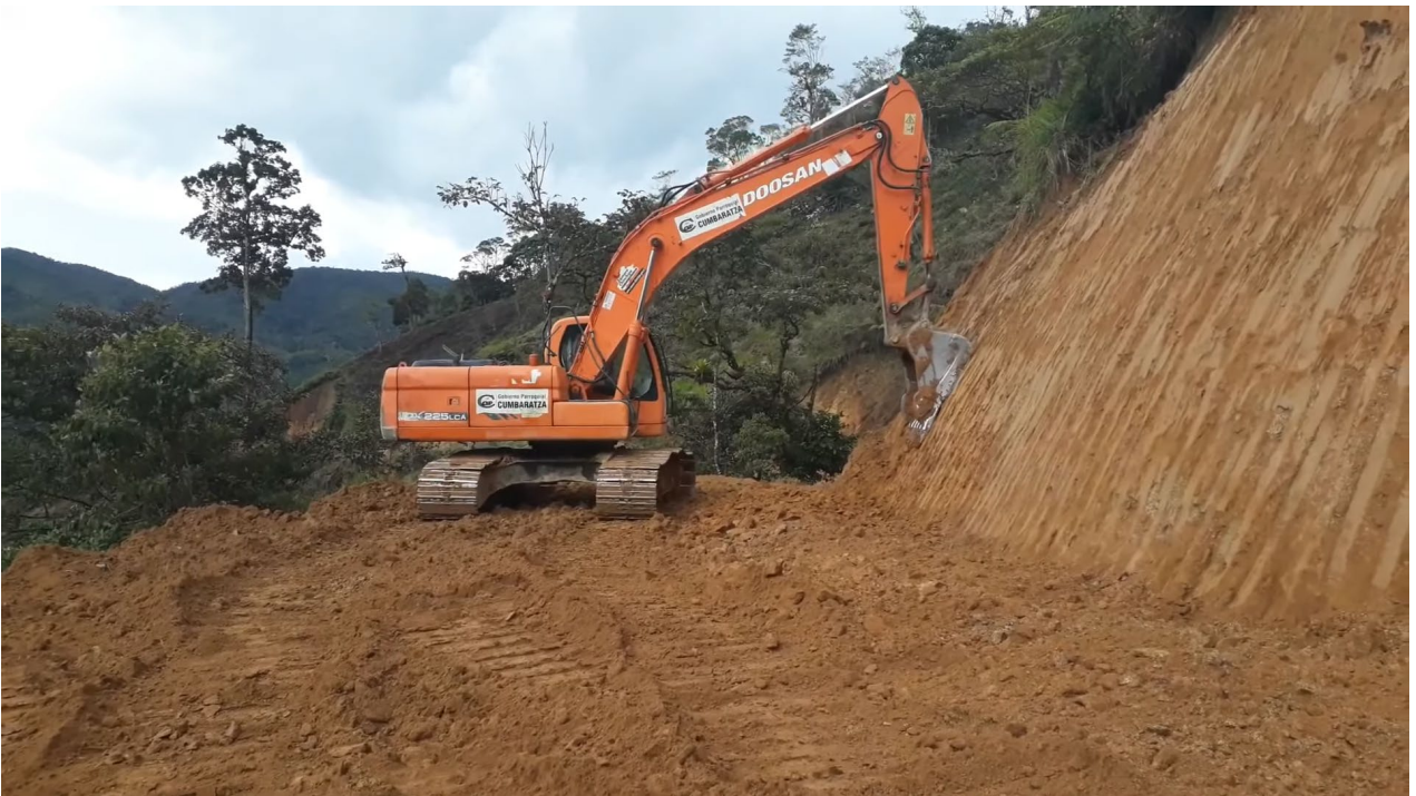
Figura 3.57: Ejemplo de perfilado de un talud
