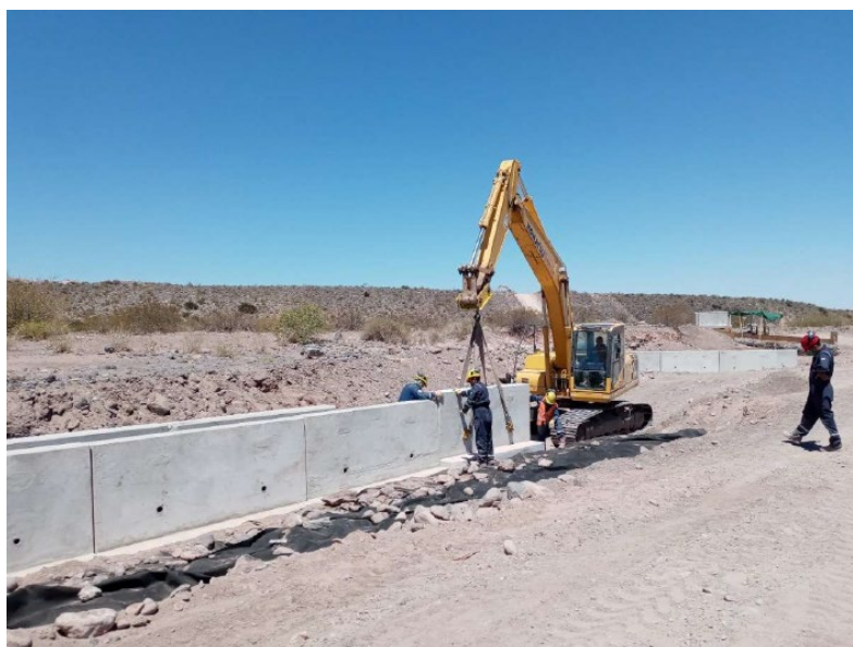
Figura 9.58: Colocación de protecciones de hormigón (Sleepers)
