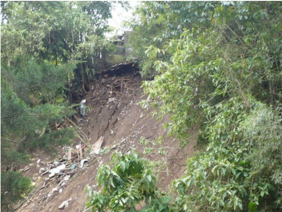
Figura 9.1 Deslizamiento de talud 1
