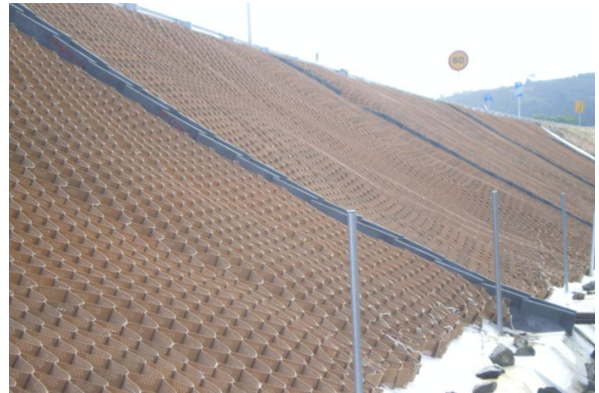
Figura 3.62: Geoceldas en estabilización de taludes.
