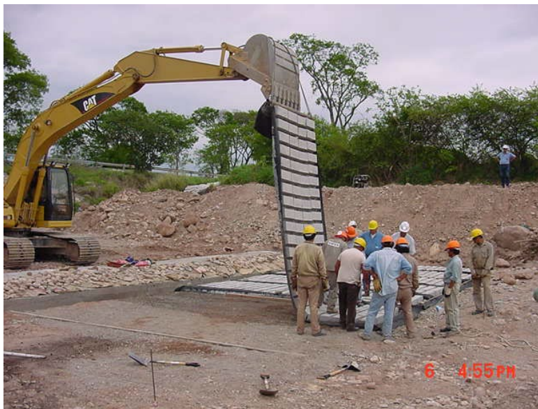
Figura 3.46: Ejemplo de manta flexible con dados de hormigón en el río Yatasto, Salta, Argentina
