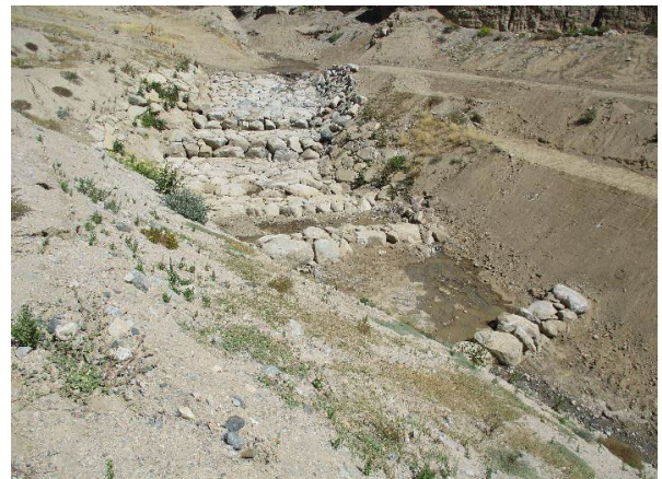
Figura 3.44: Obra de enrocado de protección de fondo – Pisco, Perú
