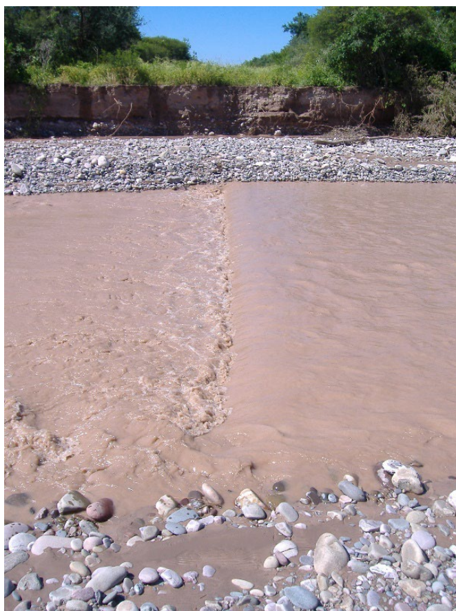
Figura 4.21: Socavación vertical localizada del lecho en un río de cauce trenzado Fuente: Transportadora de Gas del Norte
