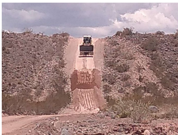
Figura 9.59: Acondicionamiento de pendiente de cerro
