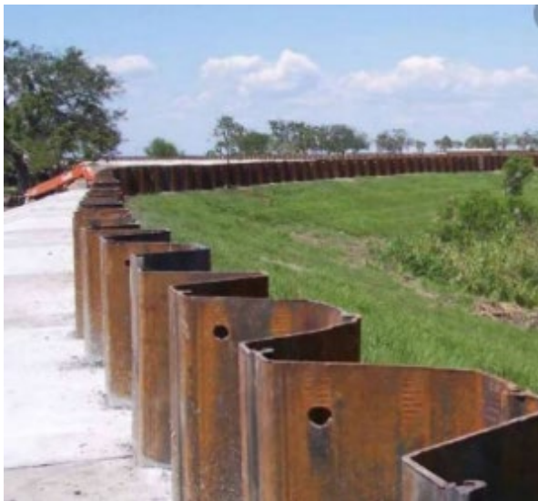
Figura 3.31: Tablestacado
