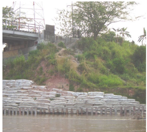
Figura 3.28: Bolsacretos en protección de estribo de puente.
