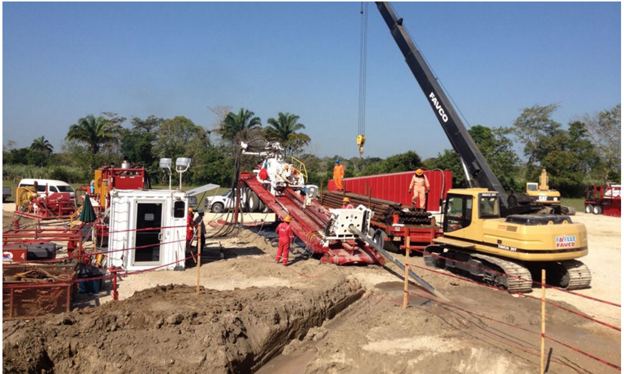
Figura 3.72: Ejemplo de equipo durante ejecución de una perforación horizontal direccionada
