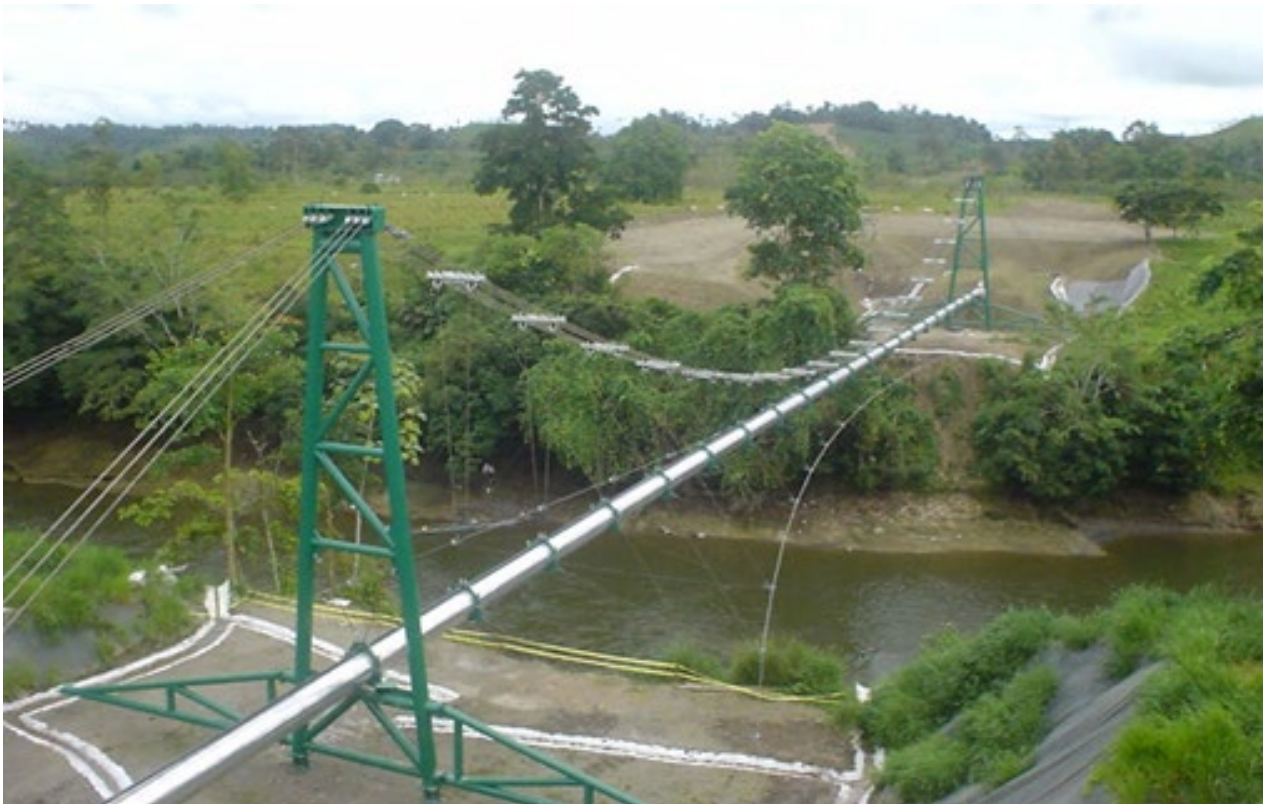
Figura 3.71: Ejemplo de cruce aéreo en ducto. Río Quinidé, Ecuador.
