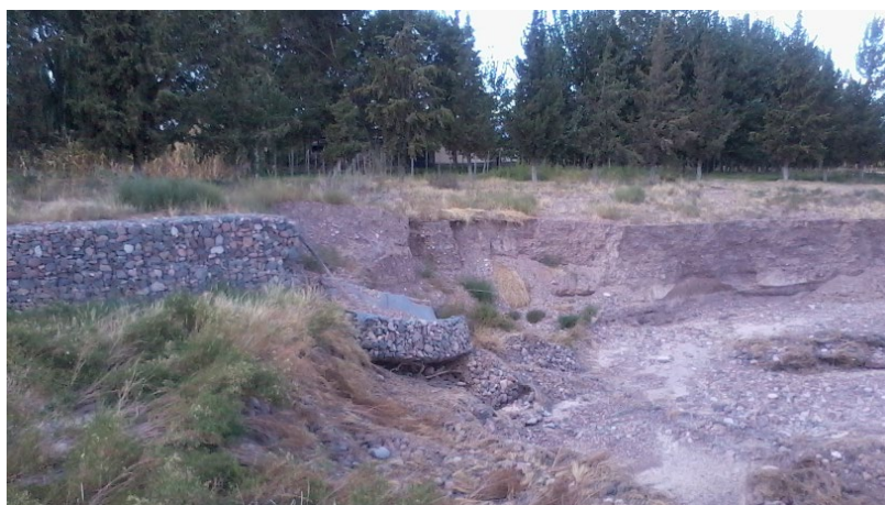
Figura 3.15: Falla por erosión del pie en cauce semipermanente
