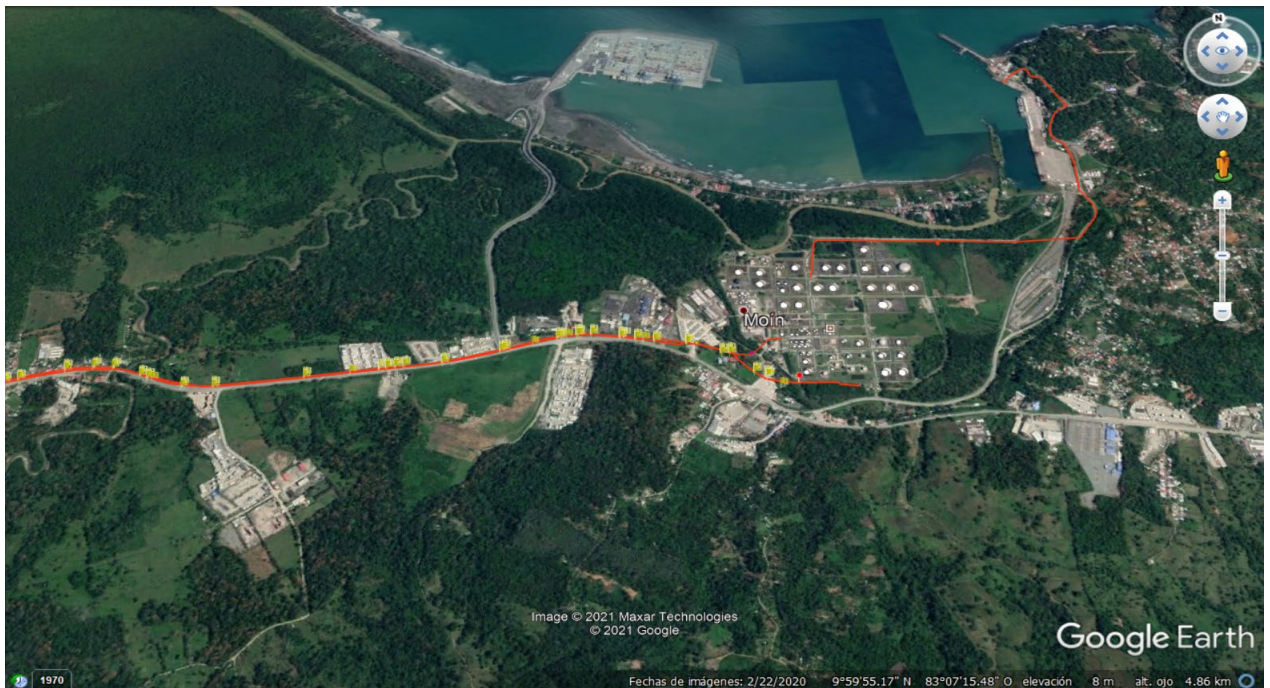
Figura 8.5: Vista general de la infraestructura Terminal Moin
