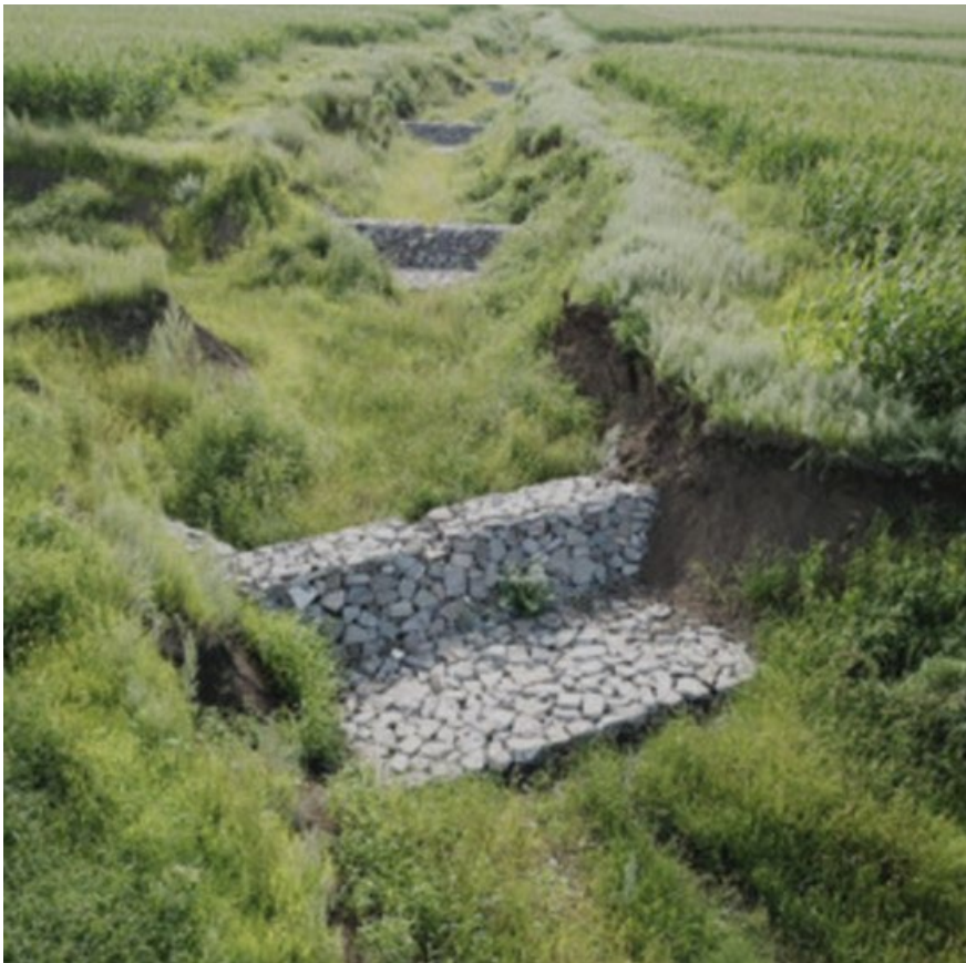
Figura 3.45: Ejemplo de check dam
