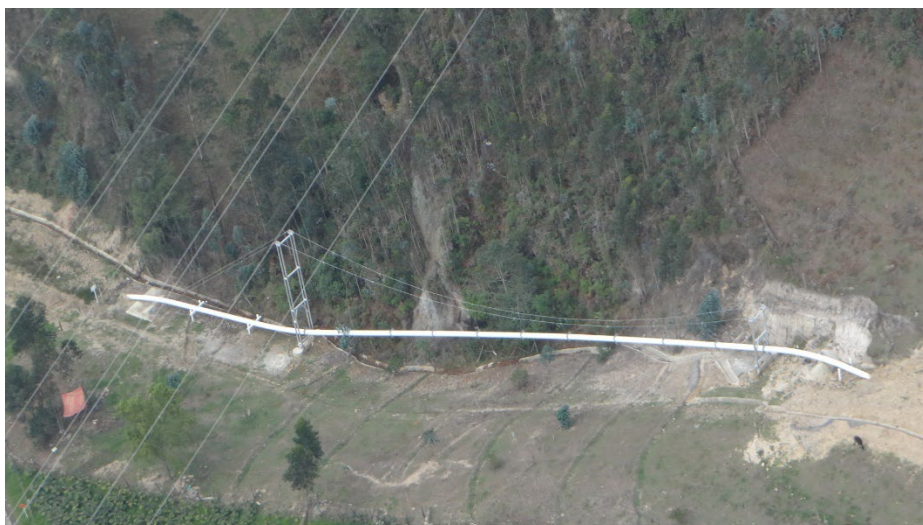
Figura 4.33: Estructura de cruce aéreo de gasoducto en DDV compartido con OCENSA
