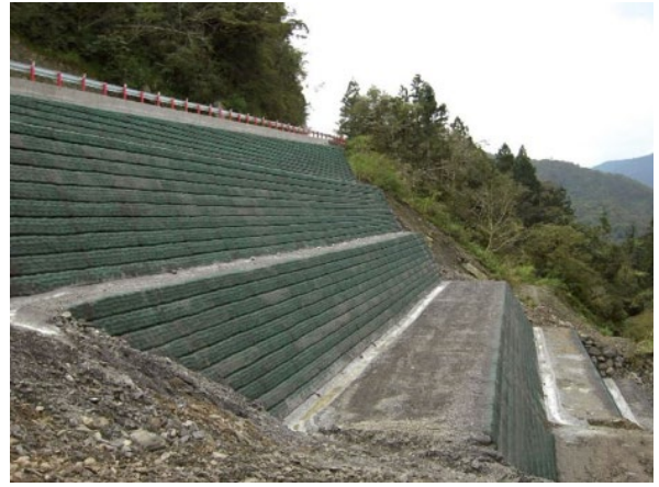
Figura 3.59: Aterrazamiento con geomembranas sembrables
