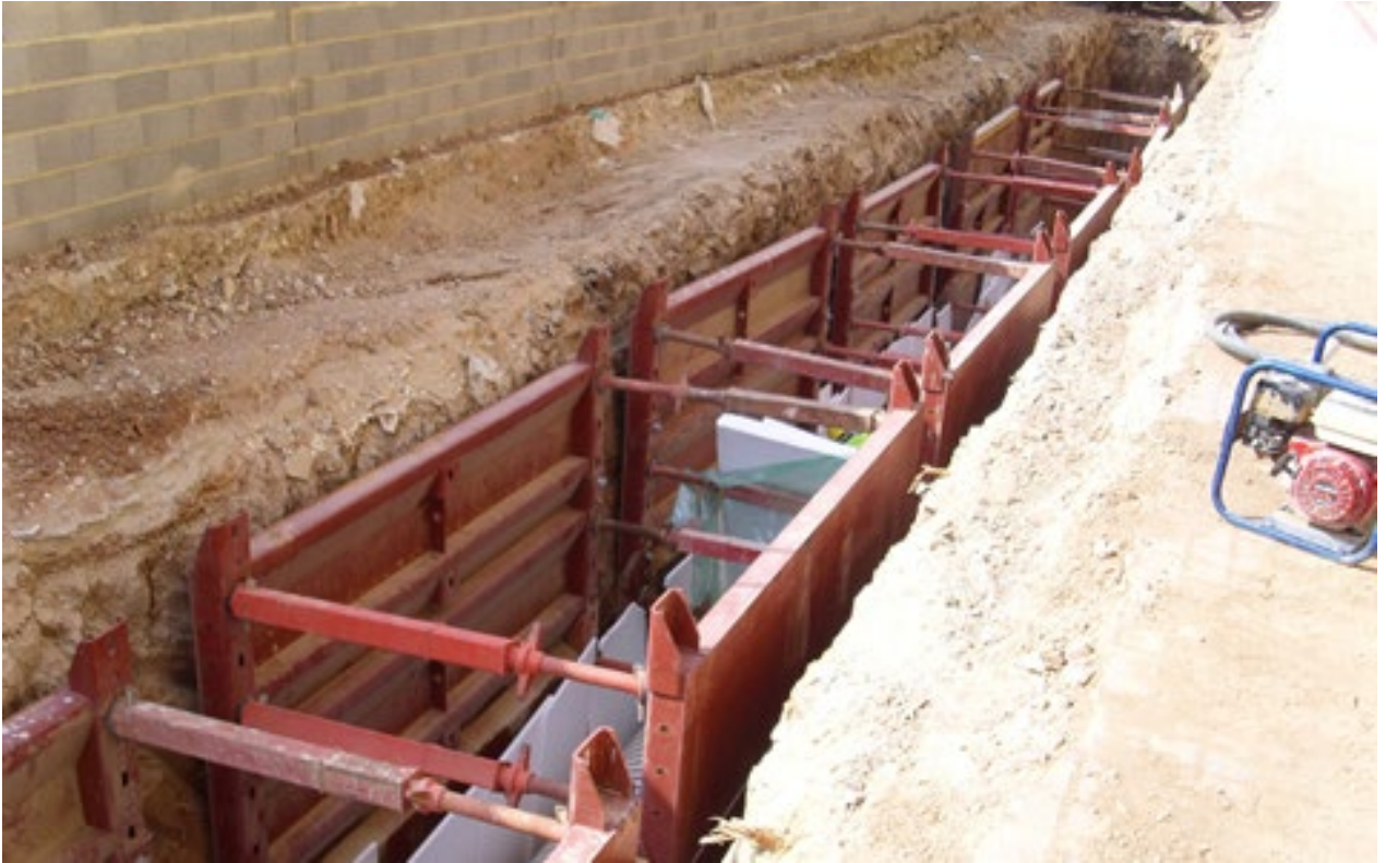
Figura 3.63: Entibamientos metálicos
