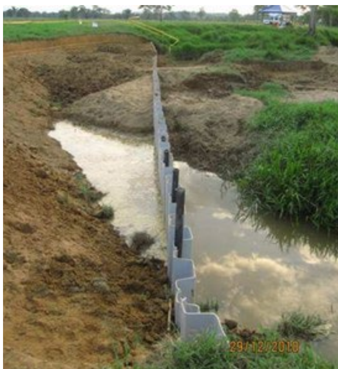
Figura 3.37: uso de tablestaca para recuperación de DDTV
