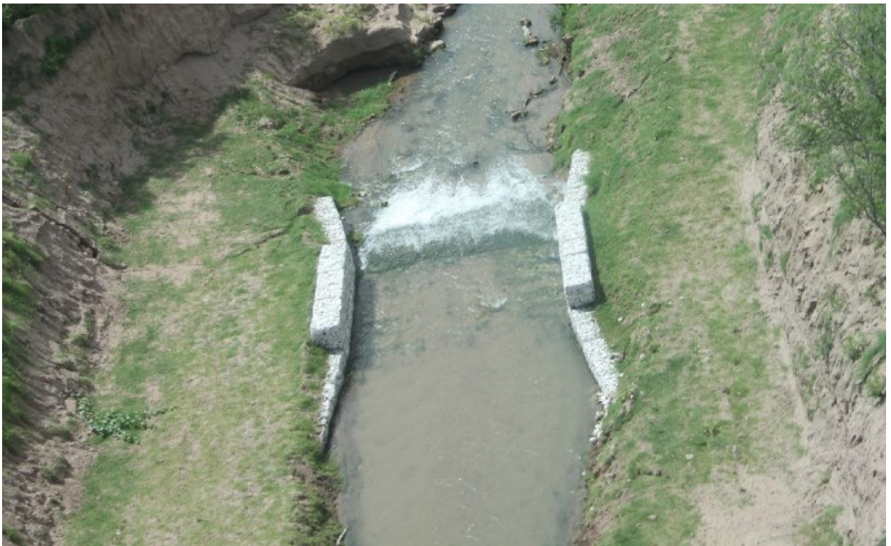
Figura 3.9: Ejemplo de cruce subfluvial en Córdoba, Argentina
