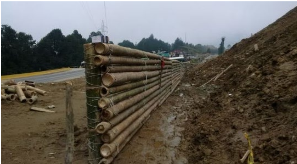
Figura 3.29: Contención inferior de pie de talud
