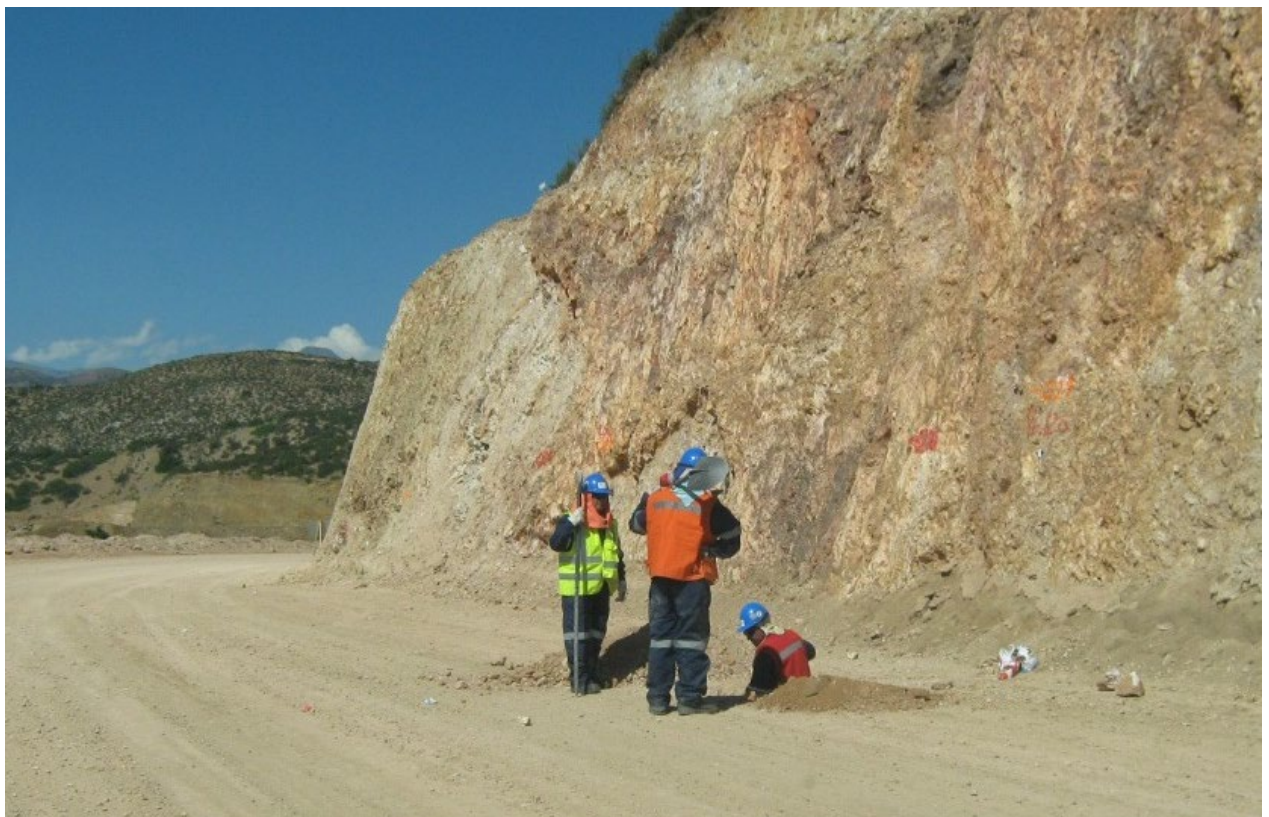
Figura 6.38 Sondeo manual directo sobre ducto
