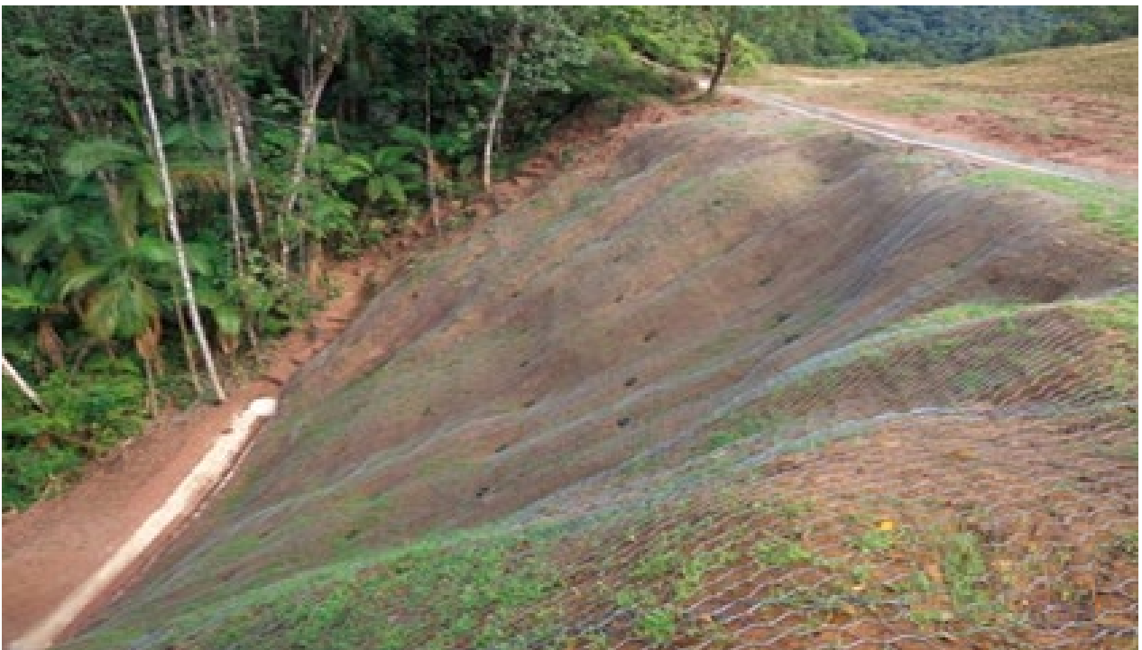
Figura 6.17 Suelo clavado con paramento en tela metálica galvanizada y revestimiento en PVC
