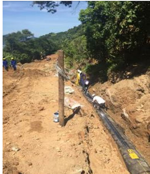
Figura 9.28 Detalle del ducto despegándose del terreno y abriendo grietas aguas arriba a medida que se iba excavando la zanja
