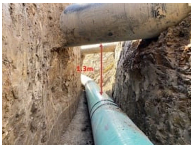
Figura 4.36 Paso de tubería por debajo de ducto existente. Se respetan distancias mínimas.
