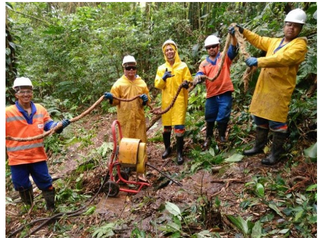
Figura 6.14 Típico equipamiento de desobstrucción de ducto de desagüe (izquierda). Raíces retiradas en el proceso de limpieza (derecha)
