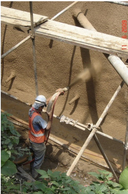
Figuras 9.12 Lanzado de concreto
