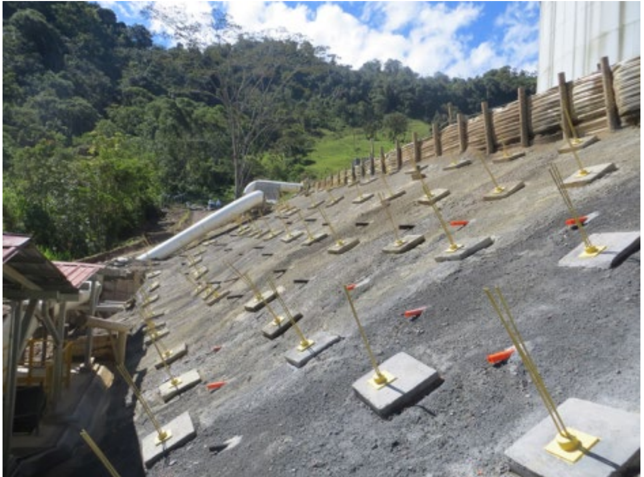
Figura 3.75: Talud estabilizado mediante anclajes, cortina de concreto y drenajes sub horizontales
