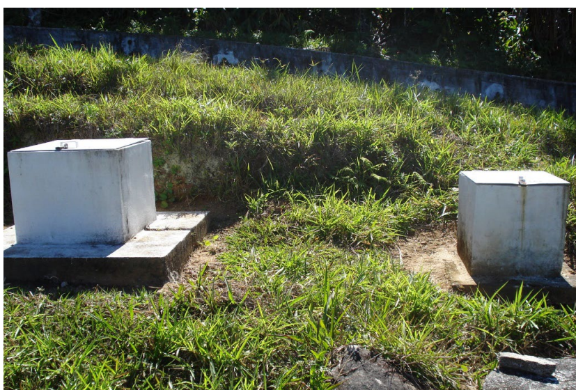
Figura 6.36 Protección de instrumento automatizado en concreto
