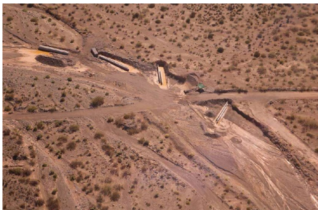
Figura 9.60: Toma aérea de la obra en construcción
