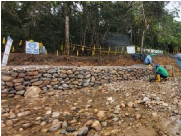
Figura 6.31 Trabajos de mantenimiento correctivo en muros de gaviones conformado por cantos de roca
