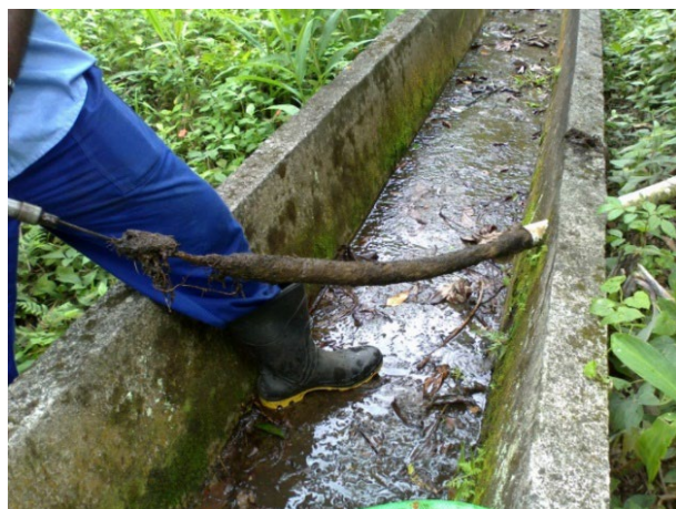
Figura 6.13 Gancho utilizado para limpieza mecánica (izquierda) y Raíces retiradas con auxilio del gancho (derecha)
