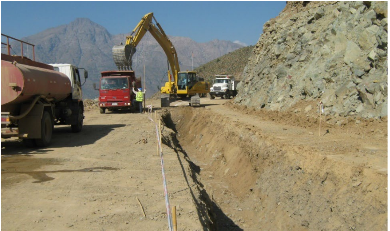
Figura 6.39 Excavación mecánica – posterior al sondeo manual directo sobre el ducto
