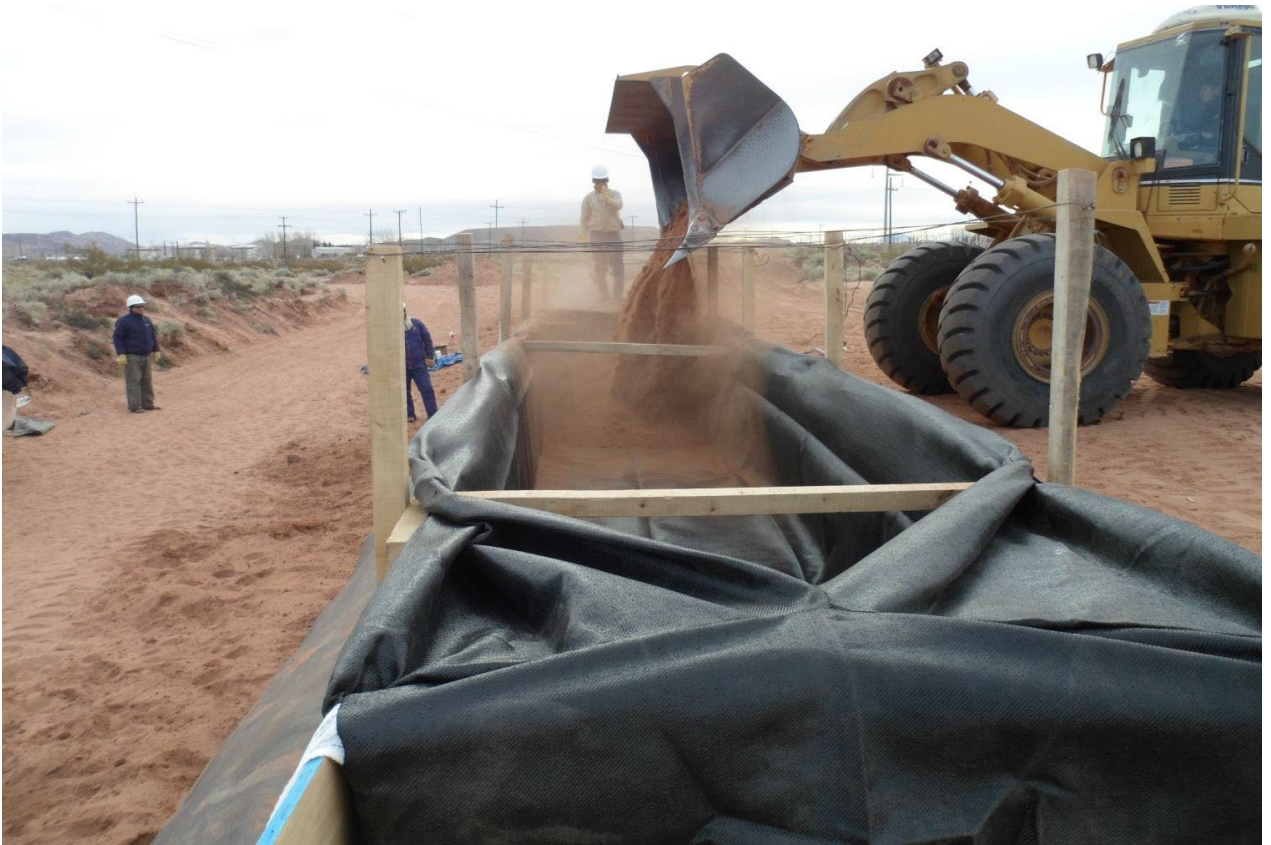
Figura 3.41: Ejemplo de llenado in situ – locación definitiva
