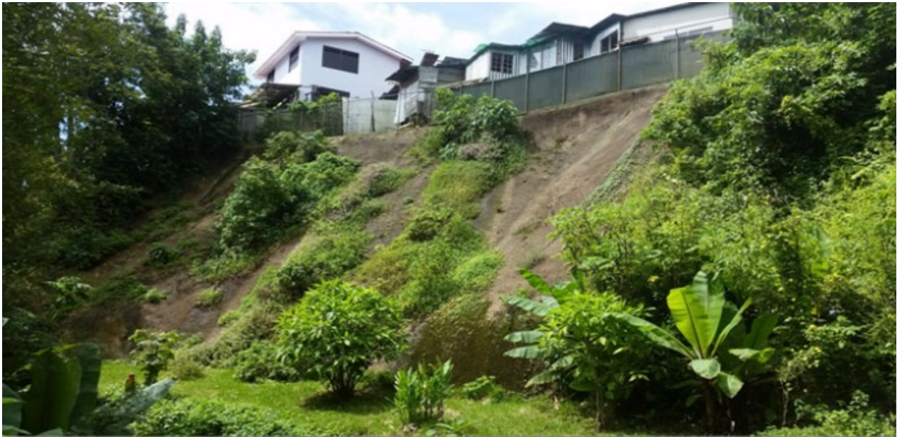
Figura 9.15 Obra integrada al entorno natural – posterior a los trabajos
