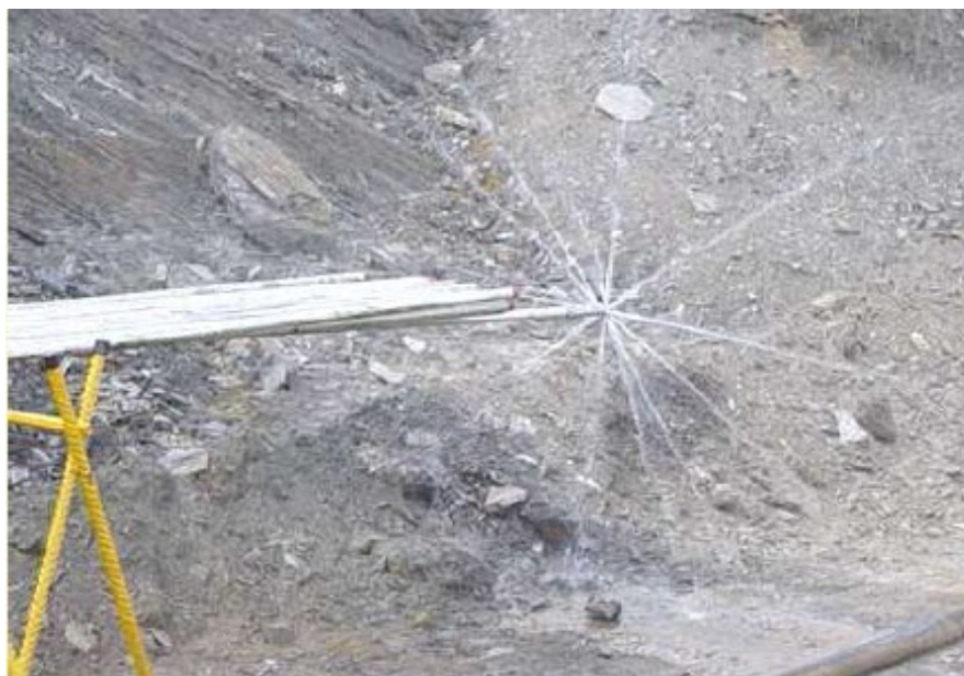
Figura 6.12 Sistema de desarrollo del DHP con voladura de los filtros
