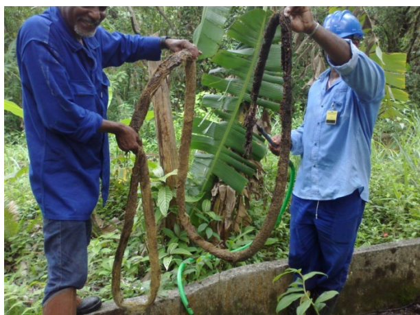
Figura 6.13 Gancho utilizado para limpieza mecánica (izquierda) y Raíces retiradas con auxilio del gancho (derecha)
