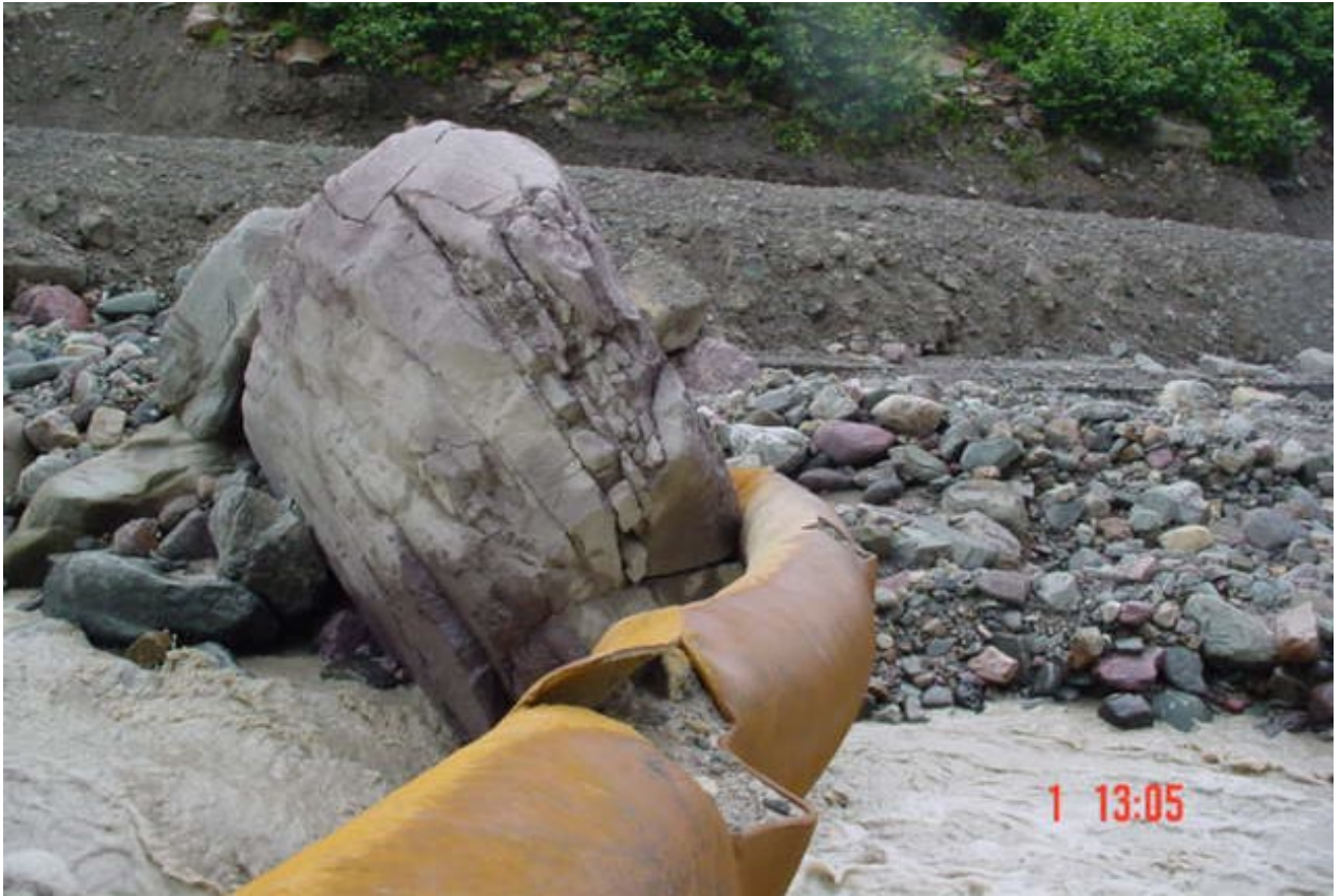
Figura 4.29 Impacto de una roca sobre un by-pass en un río de montaña sujeto a flujos de detritos
