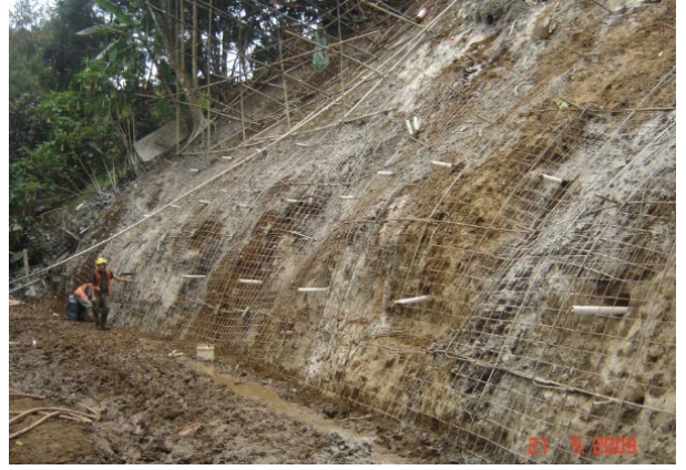
Figuras 9.11 Vista general del talud y colocación de anclajes en la base.
