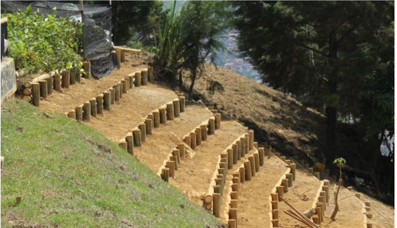
Figura 3.53: Contención de ladera
