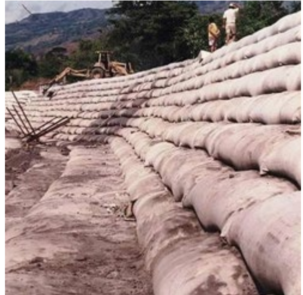
Figura 3.27 Bolsacretos en protección de talud.
