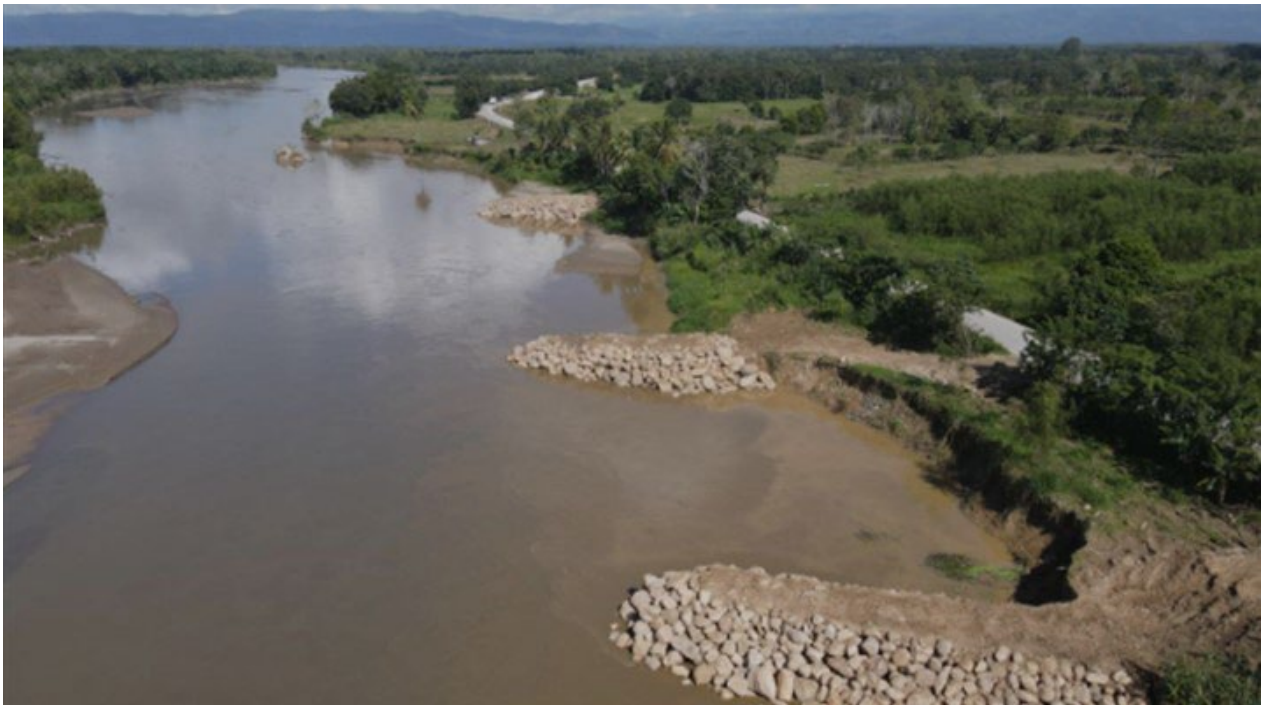
Figura 3.26: Ejemplo de espigones como defensa ribereña
