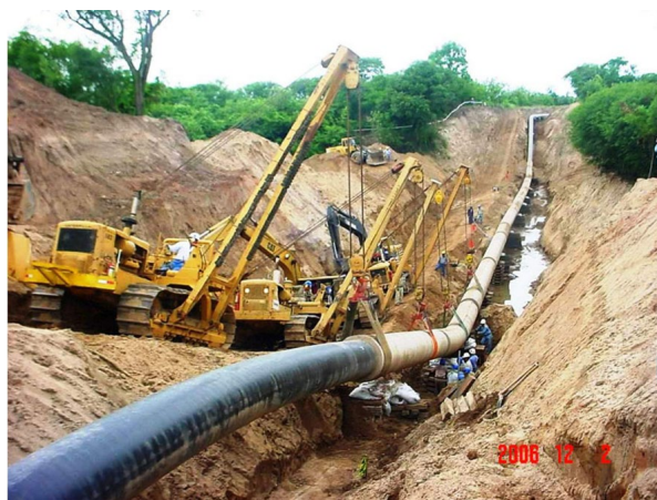
Figura 4.32 Ejemplo de actividad de construcción de un cruce con excavación a cielo abierto
