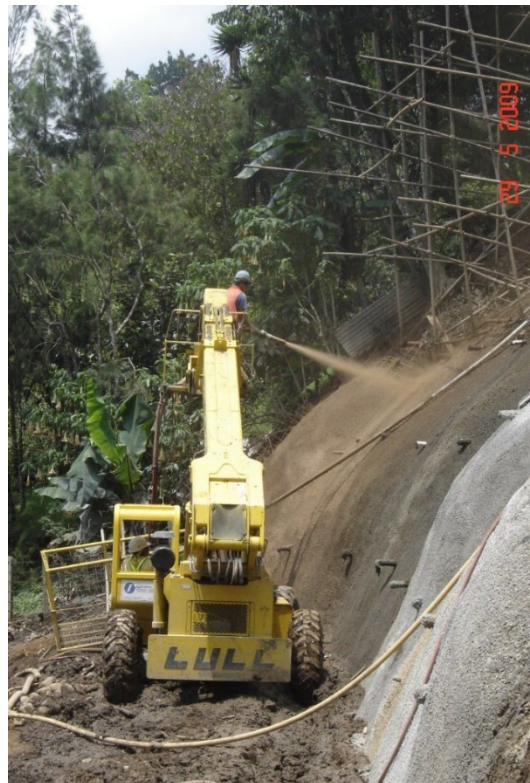
Figuras 9.12 Lanzado de concreto
