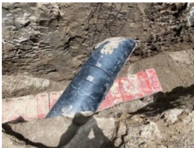
Figura 4.37: Proceso de colocación de placas de concreto protegiendo tubería inferior en cruce.
