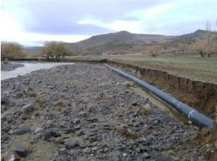
Figura 4.26 Corrimiento lateral de margen con ducto paralelo a la misma en un río de montaña de la Patagonia Argentina Fuente: Transportadora de Gas del Norte
