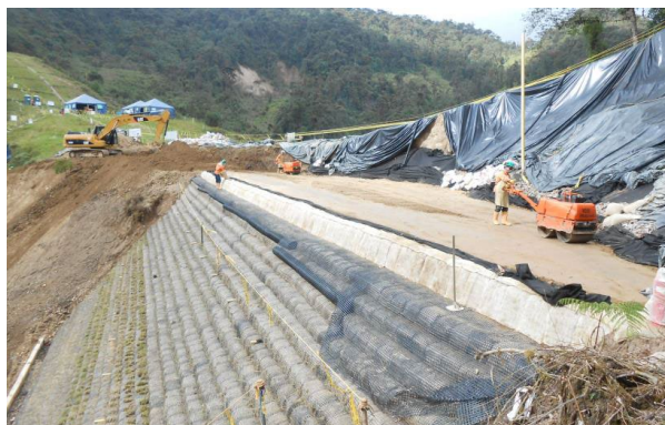
Figura 9.36 Detalle de la compactación en la construcción del muro y cara exterior con sacos de fique rellenos de suelo.
