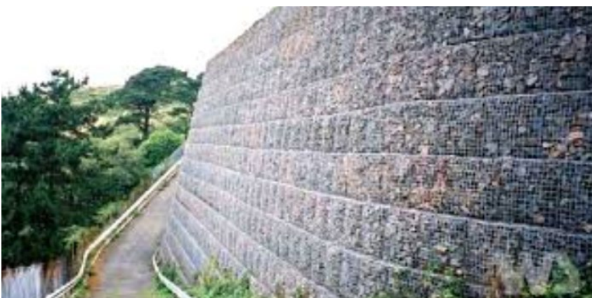
Figura 3.51: Contención lateral con muro de gaviones.
