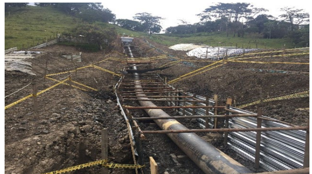
Figura 6.41 Apertura de zanja para permitir recuperación de deformación del ducto
