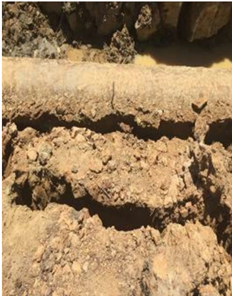
Figura 9.28 Detalle del ducto despegándose del terreno y abriendo grietas aguas arriba a medida que se iba excavando la zanja
