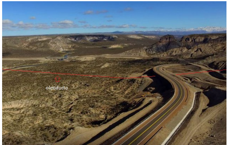
Figura 3.7: nueva Ruta Nacional 40 y su cruce con el oleoducto
