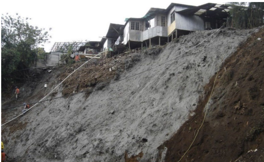
Figura 9.8 Vista general del talud a estabilizar una vez concluidas las actividades de limpieza
