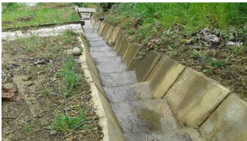
Figura 6.9 Vista general de canal con mantenimiento finalizado
