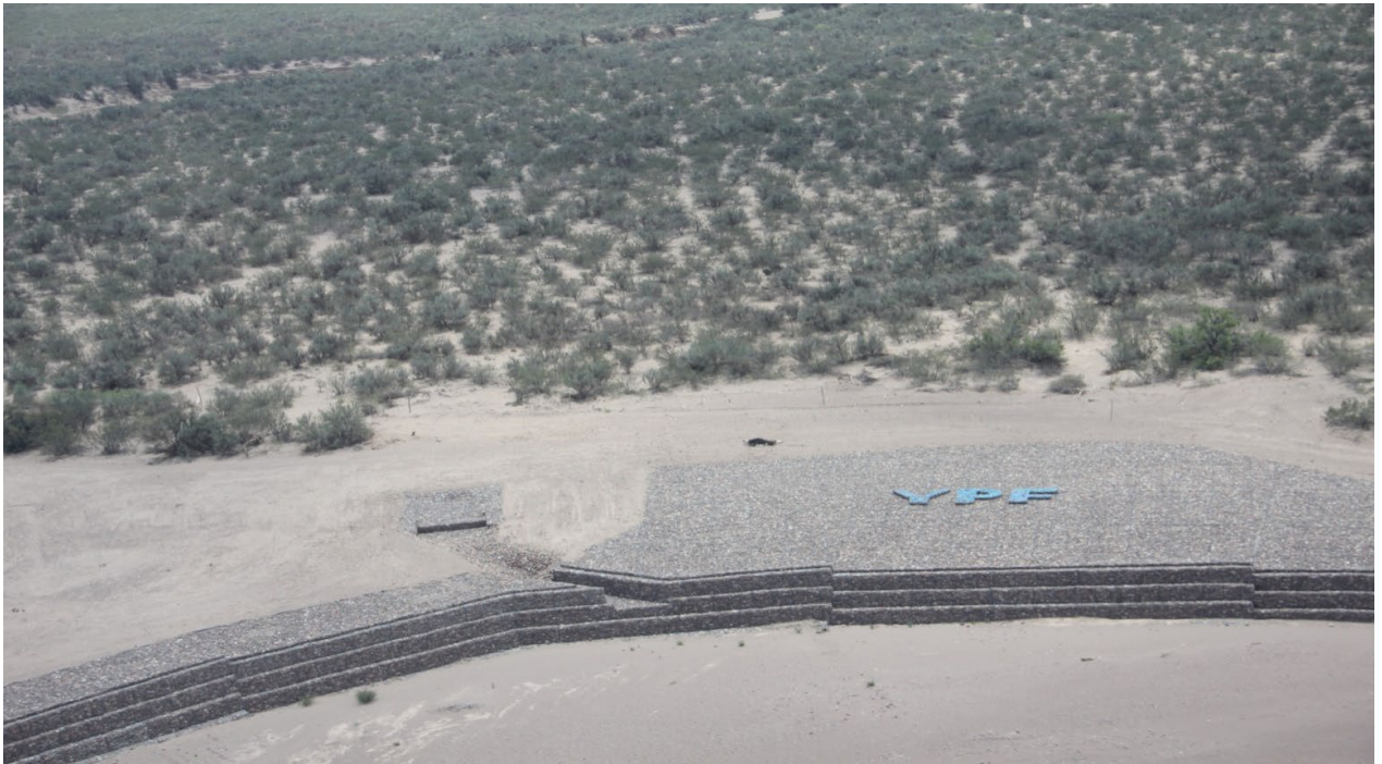
Figura 3.14: Obra de protección de margen con gaviones - Finalizada
