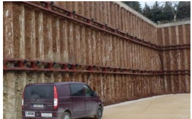
Figura 3.50: Pilotaje como contención lateral.
