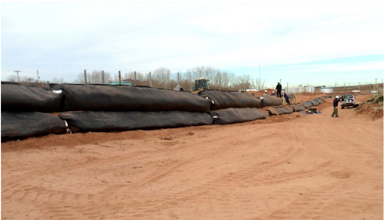
Figura 3.42: Finalización de obra con geotubos – locación definitiva.
