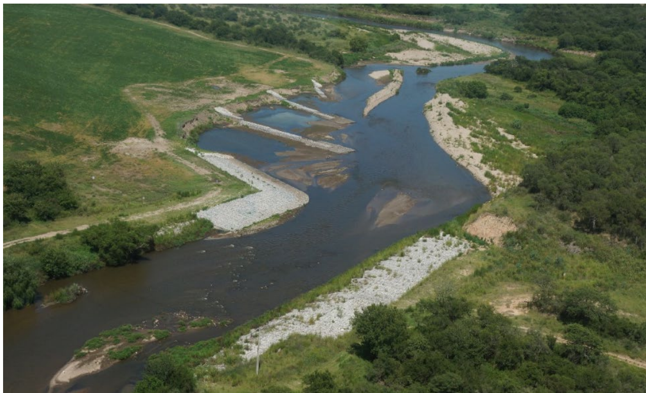
Figura 3.43: Obra de protección de márgenes y solera del Río Suquía – TGN. Córdoba, Argentina
