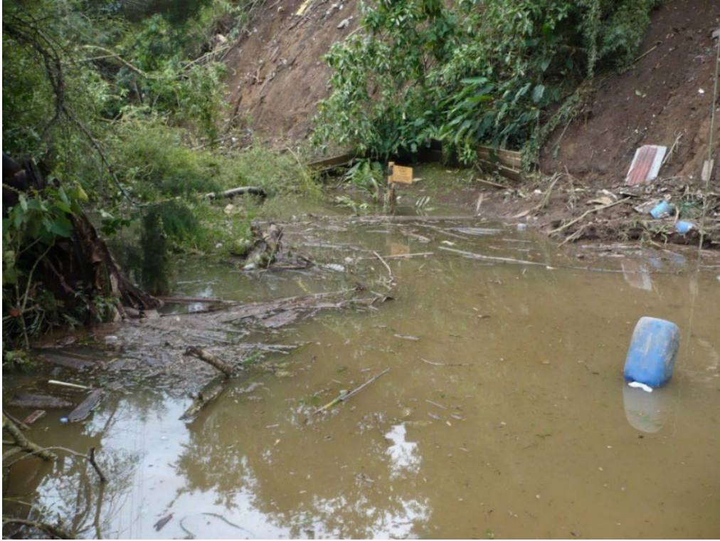
Figura 9.2 Base del talud inundada 2
