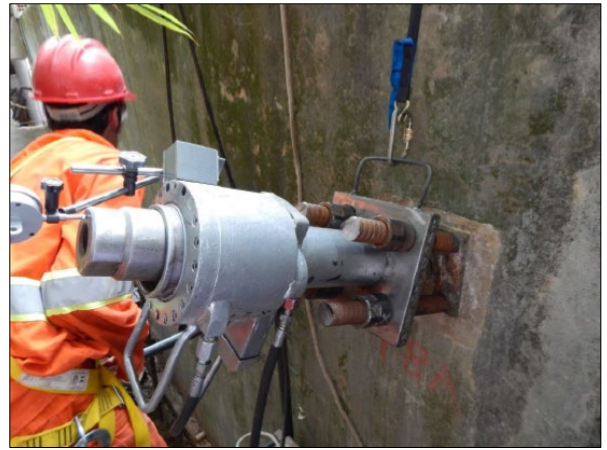
Figura 6.24 Ensayo de verificación de carga en tirante
