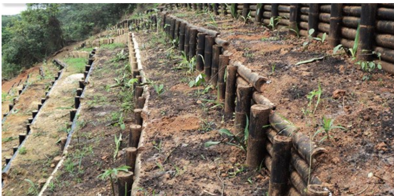
Figura 3.30: Ejemplo de trinchos a media ladera
