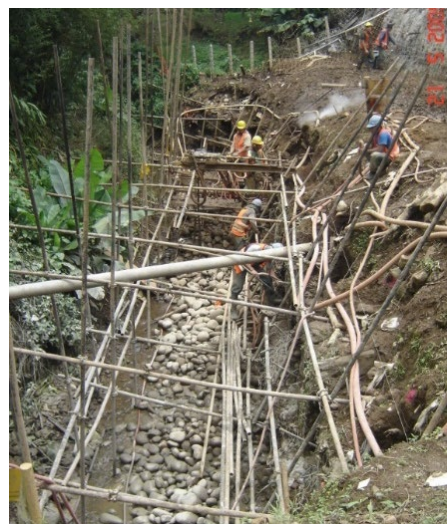
Figuras 9.10 Vista de detalle de talud revestido (izquierda). Vista general de instalación de anclajes en la base del talud (derecha)
