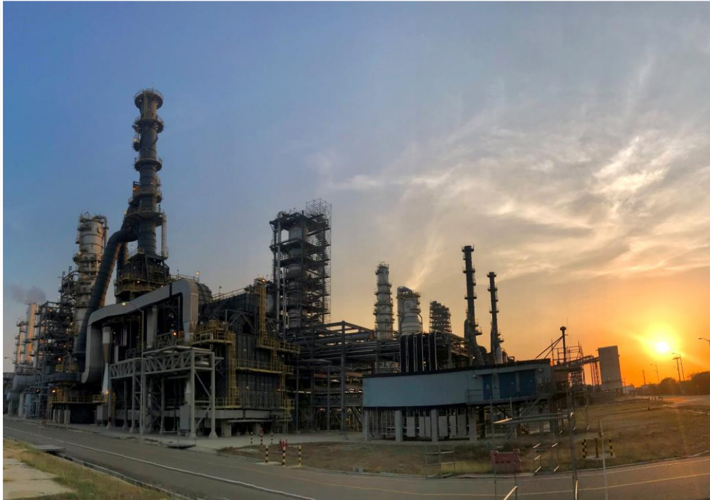
Unidad de Hidrocrqueo – Ecopetrol Cartagena
